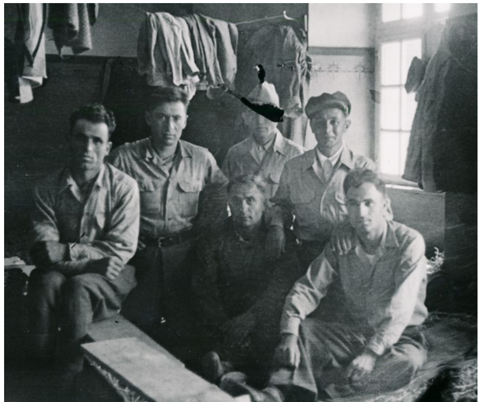
Eine Gruppe kaukasischer Internierter im Lager Attiswil, Frühjahr 1945. Quelle: CH-BAR#E5791#1000/949#2547*
