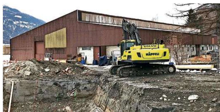
Der Abrissbagger muss warten: Obwohl schon rund um die Reithalle gebaut wird, wollen die Reiter ihren Baurechtsvertrag nicht vorzeitig auflösen. (NW)
